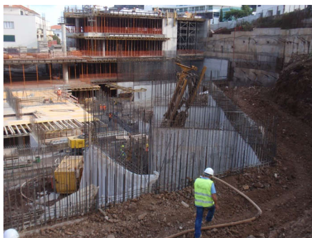
Figura 17 – Execução em socalcos e com contrafortes
