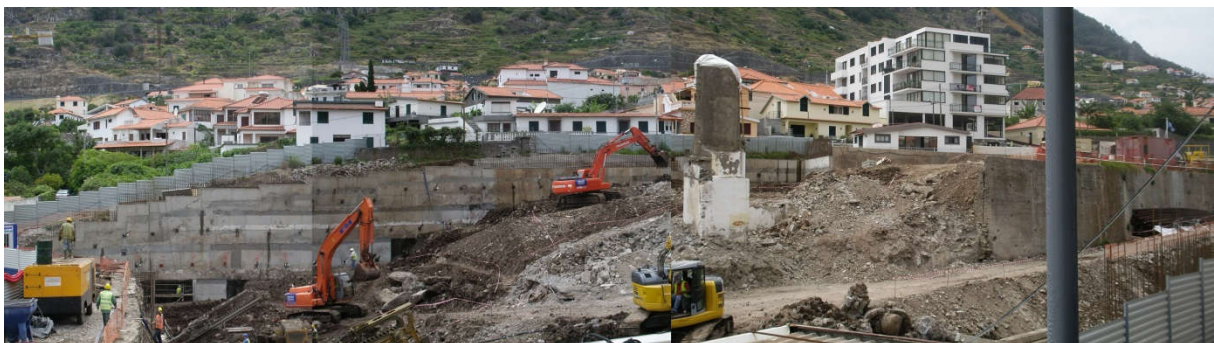
Figura 5 – Posição dos trabalhos da cortina de contenção poente em agosto de 2008
